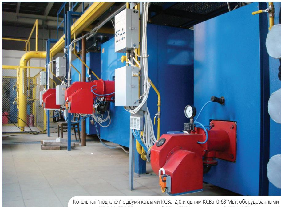
Котельная "под ключ" с двумя котлами КСВа-2,0 и одним КСВа-0,63 Мвт, оборудованными горелками ГГБ-200, ГГБ-75, автоматикой "барс ЗВП" производства АОЗТ ИЦ "Укргазтехника"
